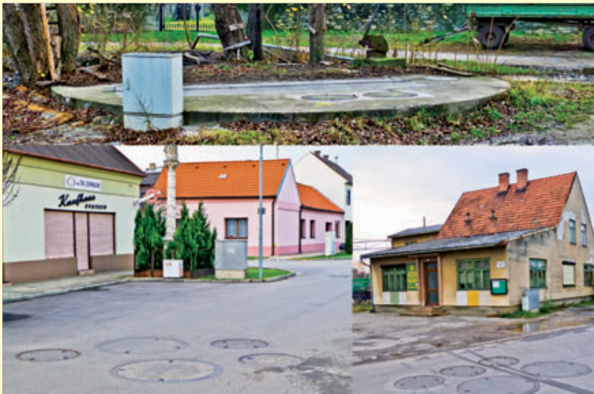
Pumpstationen in Frauenkirchen.
